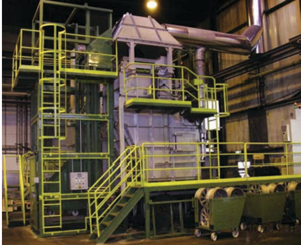
Fig.5: Elevador de carga y cámara precalentamiento con sensor de nivel
