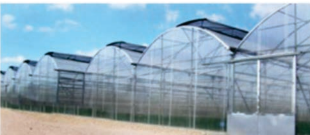
Fig. 4 Invernadero con Techumbre Curva.
